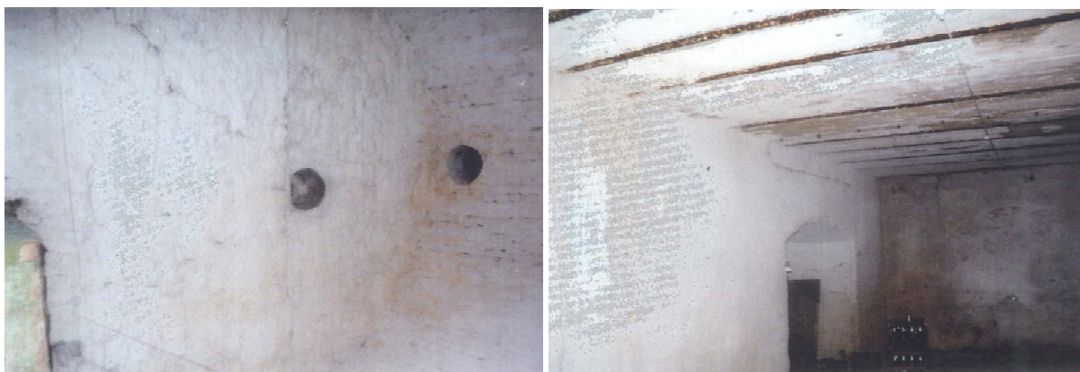
Foto 8. Tonnvõlvid läänepoolses ruumis ja metalltaladele toetava võlvistikuga laed (ümberehitatud) idapoolses kahes ruumis.
