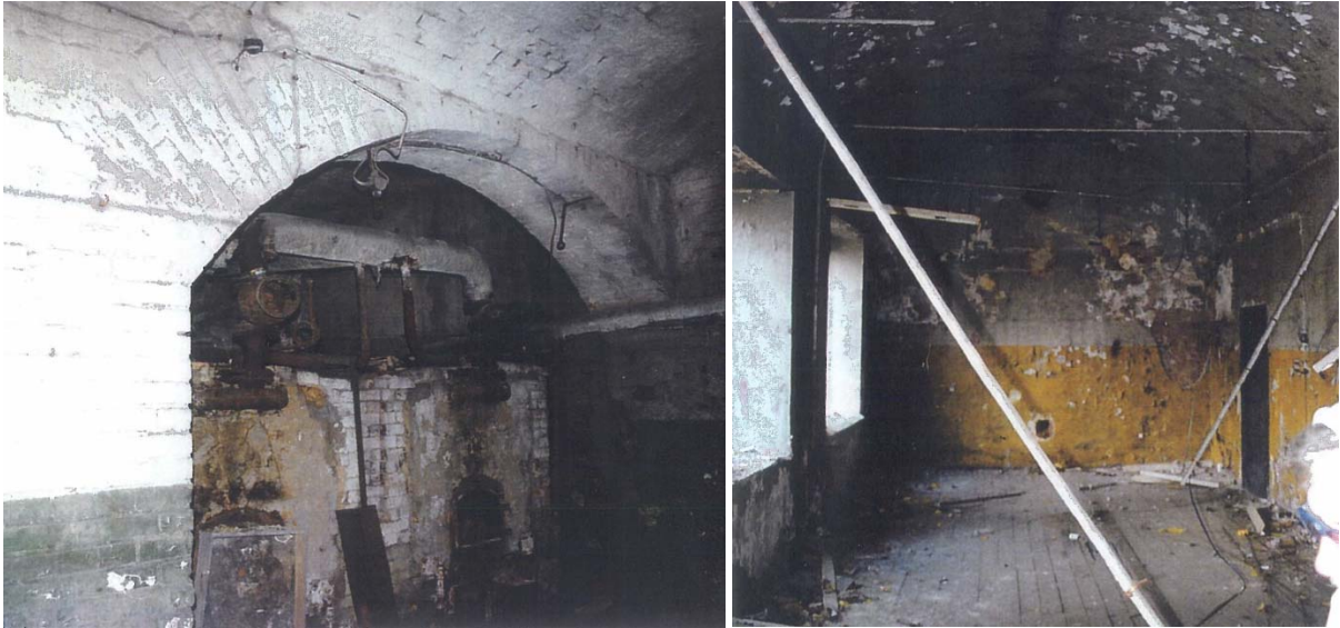
Foto 9. Tonnvõlvidega 1876. aastal ehitatud osa (pahemal) ja tonnvõlv I korrusel ruumis 7.
