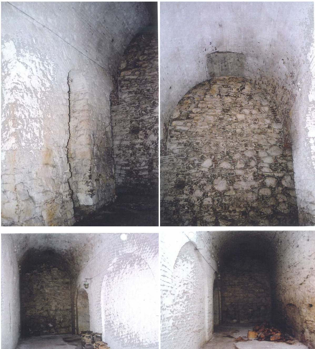
Foto 7. Tonnvõlvid Toome poolse hooneosa läänepoolses ruumis ja nišid keskses ruumis.
