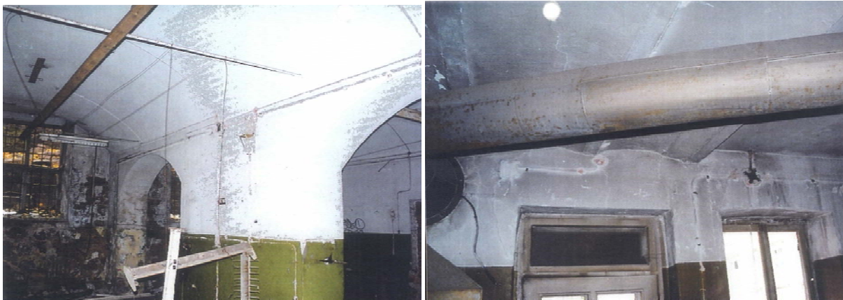
Foto 10. Tonnvõlvid ja keskne sammus I korruse ruumis 9 (pahemal) ja tänavaäärse hoone I korruse võlvitisega lagi.
